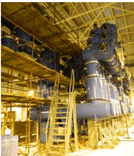
Монтаж КРУЭ-500 кВ на ПС «Каскадная»
